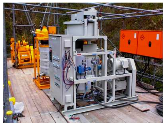
ユニット設置状況
